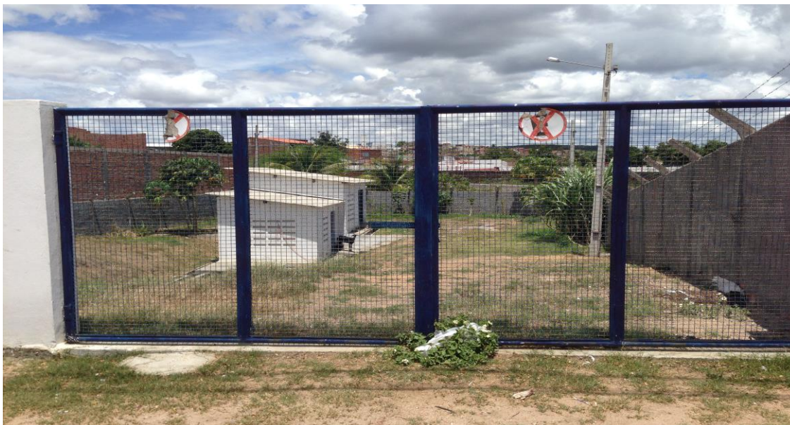
Figura 10. Estação Elevatória de Esgotos Fonte: CASAL/2015
